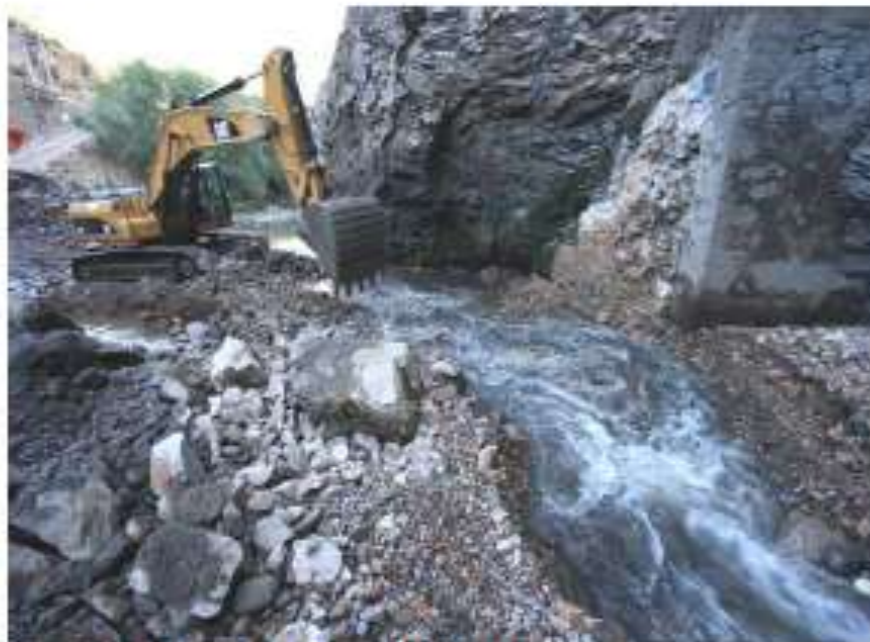
Retirada de escombros
