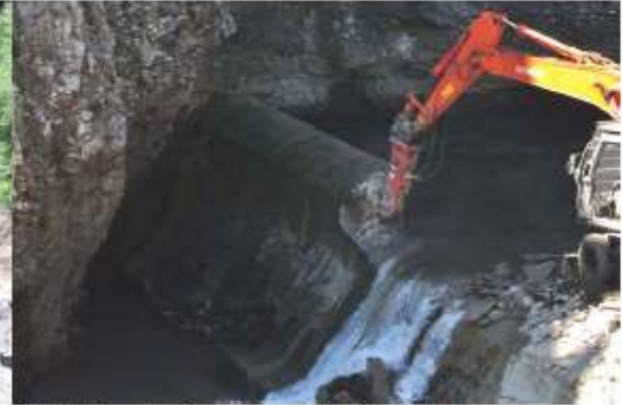
Detalle de la demolición del muro
