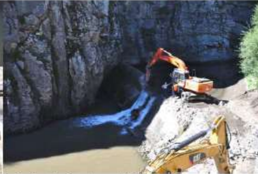
Inicio de la demolición del muro
